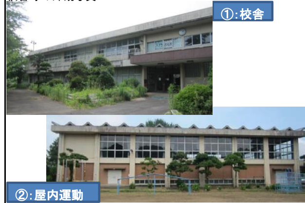
校舎等の外観写真
