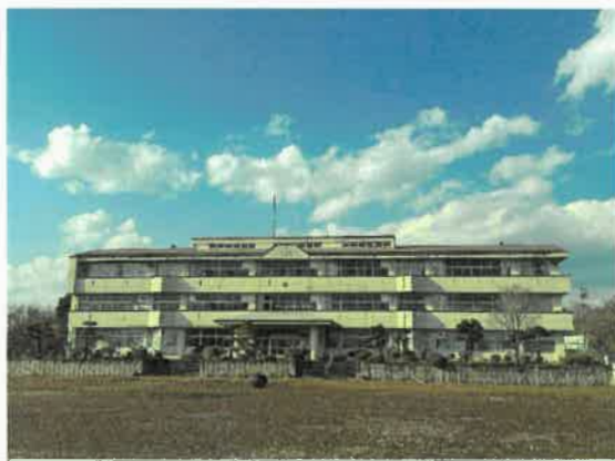
校舎等の外観写真
