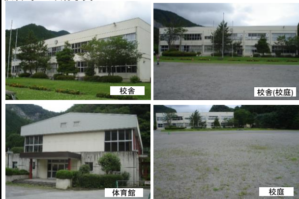
校舎等の外観写真
