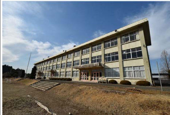
校舎等の外観写真
