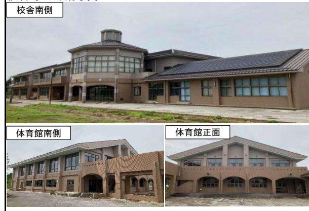
校舎等の外観写真
