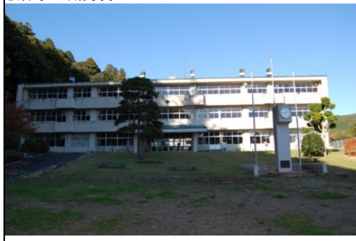
校舎等の外観写真
