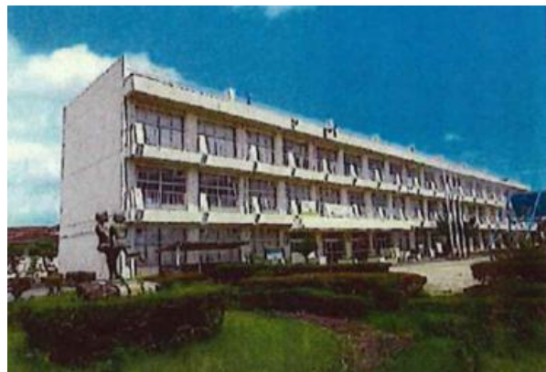
校舎等の外観写真
