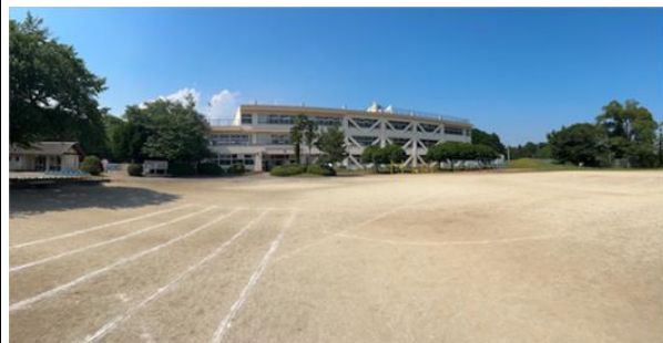
校舎等の外観写真
