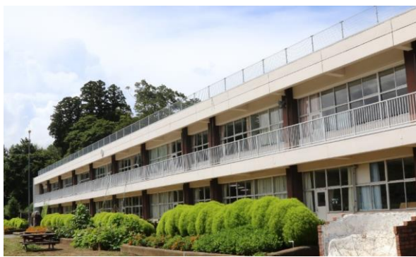
校舎等の外観写真
