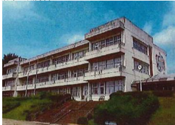
校舎等の外観写真
