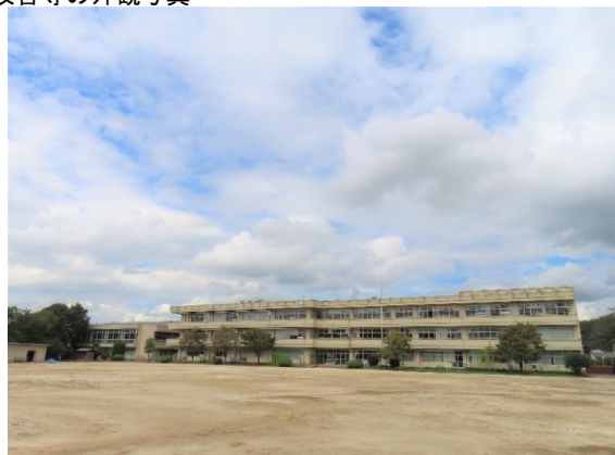
校舎等の外観写真
