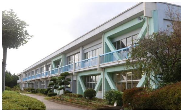
校舎等の外観写真
