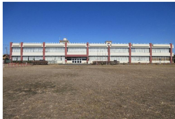
校舎等の外観写真
