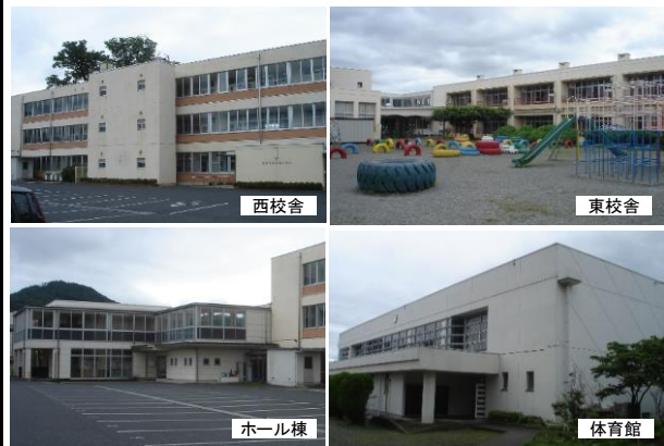
校舎等の外観写真
