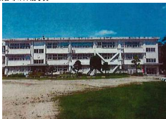
校舎等の外観写真
