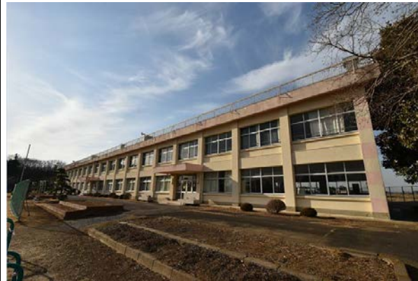
校舎等の外観写真
