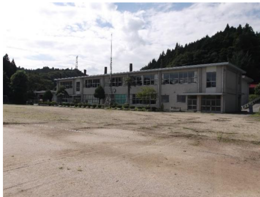
校舎等の外観写真
