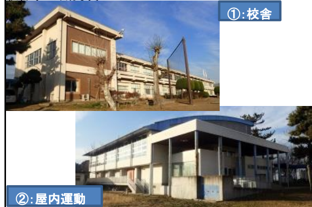
校舎等の外観写真
