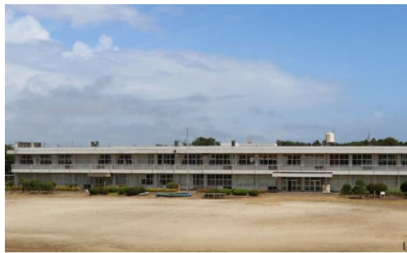
校舎等の外観写真
