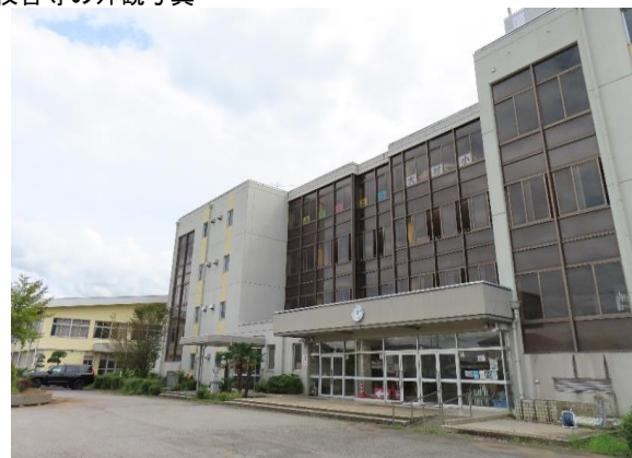
校舎等の外観写真
