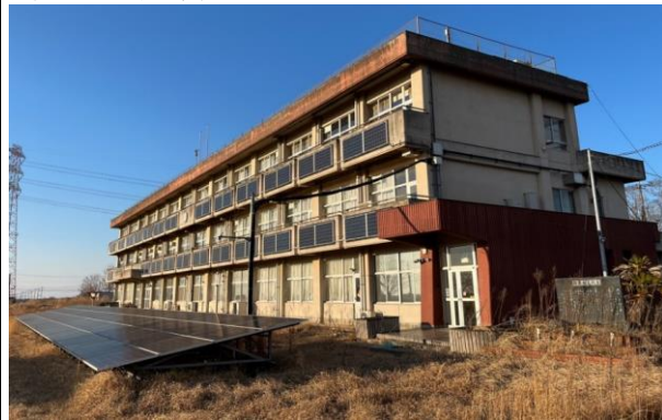
校舎等の外観写真
