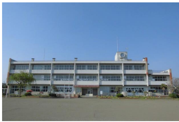
校舎等の外観写真
