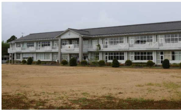
校舎等の外観写真
