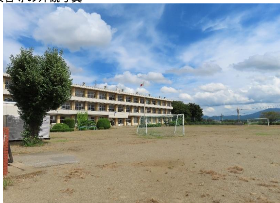
校舎等の外観写真
