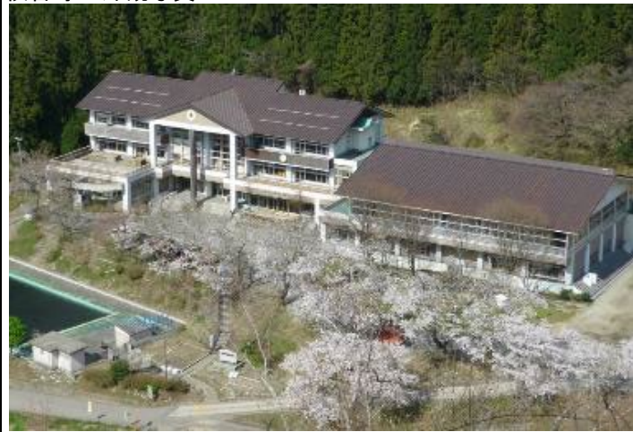
校舎等の外観写真
