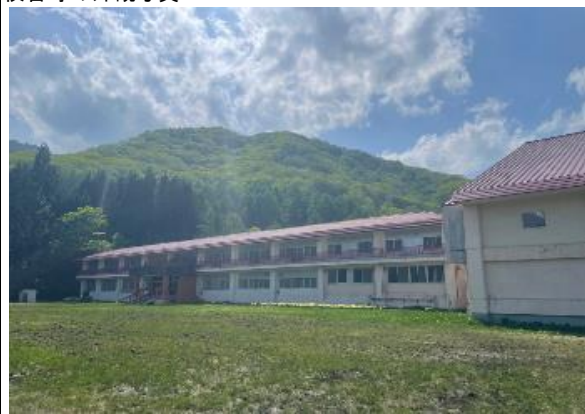
校舎等の外観写真
