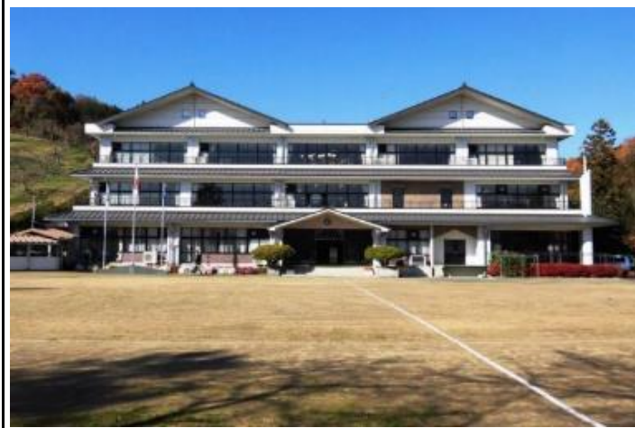
校舎等の外観写真
