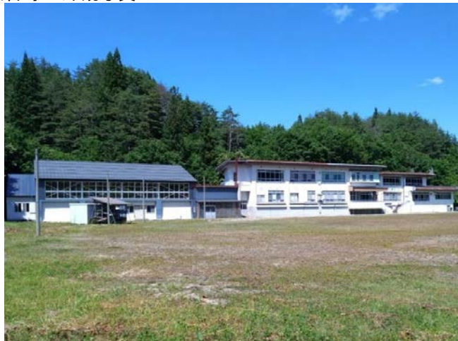
校舎等の外観写真
