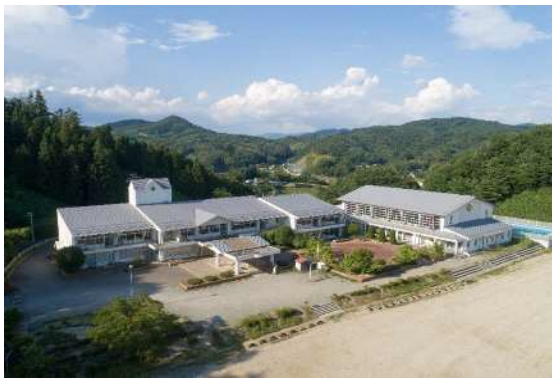
校舎等の外観写真
