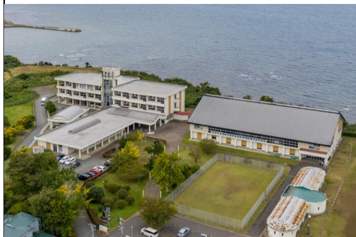
校舎等の外観写真
