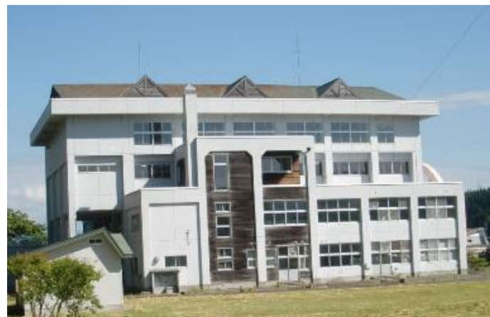
校舎等の外観写真
