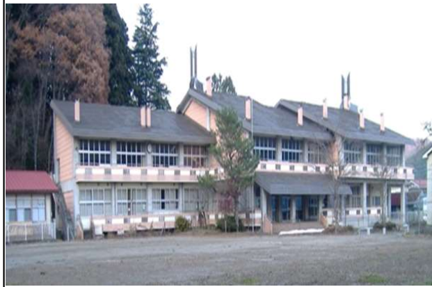
校舎等の外観写真
