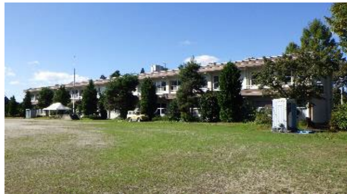
校舎等の外観写真
