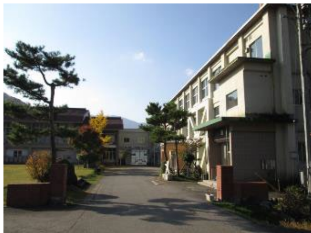
校舎等の外観写真
