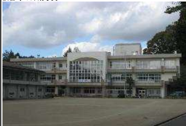
校舎等の外観写真
