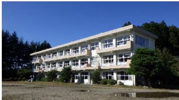
校舎等の外観写真
