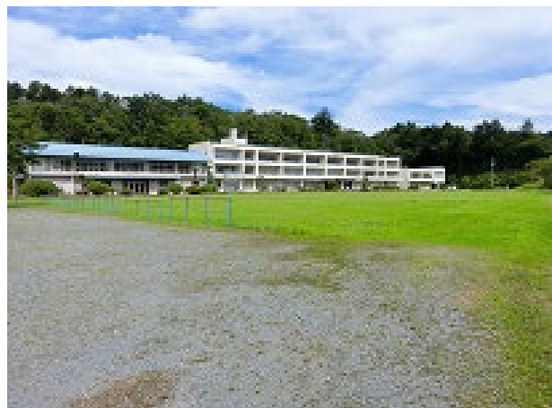
校舎等の外観写真
