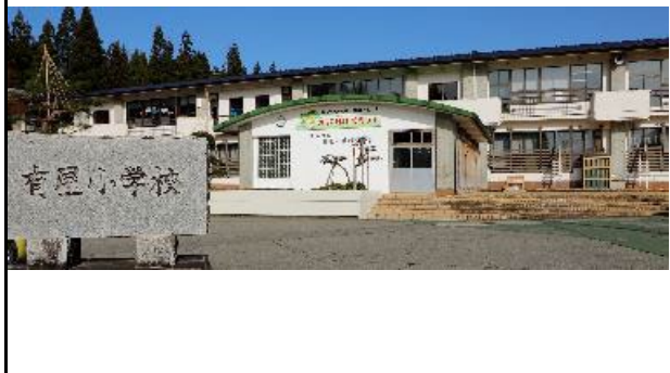
校舎等の外観写真
