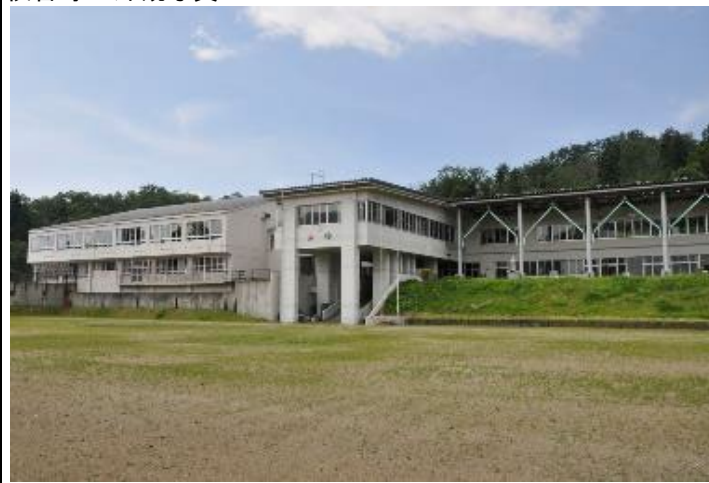
校舎等の外観写真
