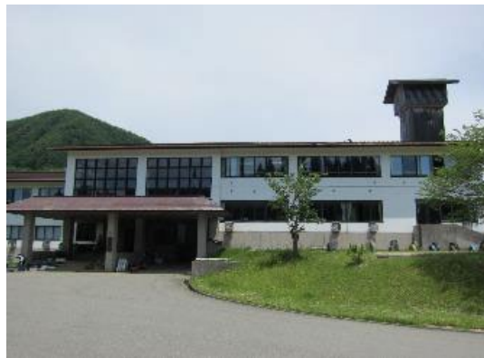
校舎等の外観写真
