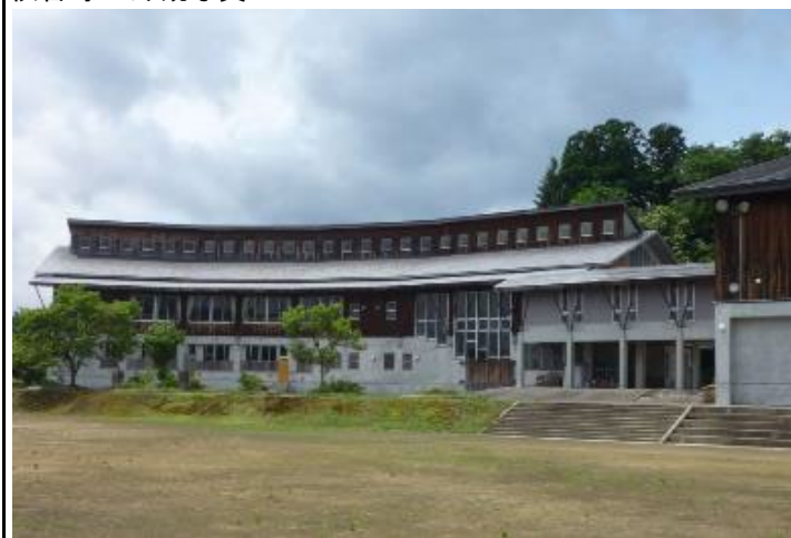
校舎等の外観写真
