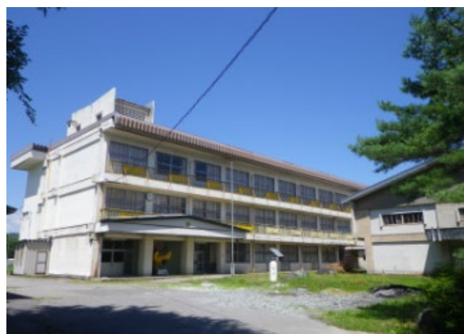
校舎等の外観写真
