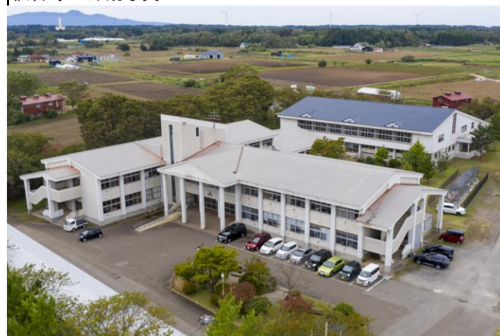
校舎等の外観写真
