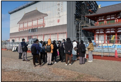
平城宮跡東楼復原現場視察
