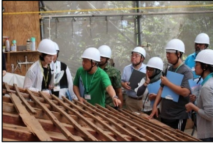
県指定文化財建造物修理現場での臨地研修
