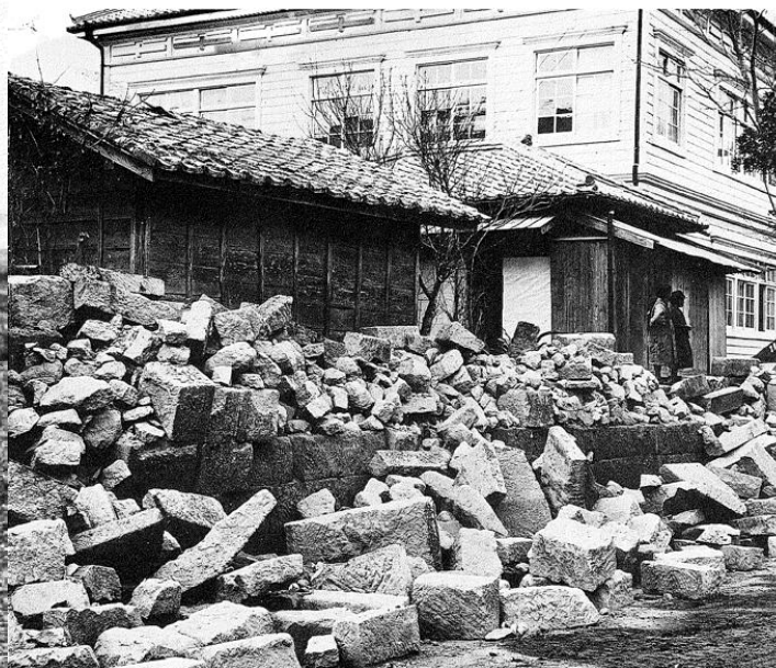
地震により倒壊した鹿児島市内の石垣
