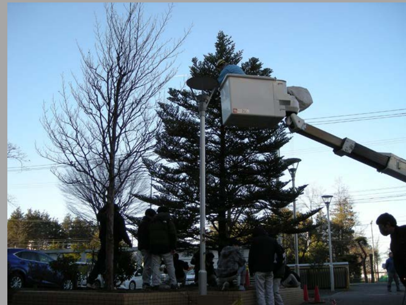
イルミネーション工事
