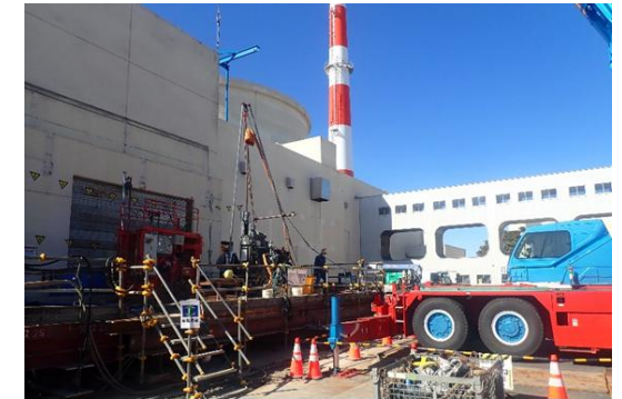
地盤改良の施工状況
