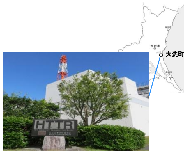
HTTR(高温工学試験研究炉)
