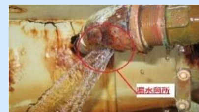
配管の破損
