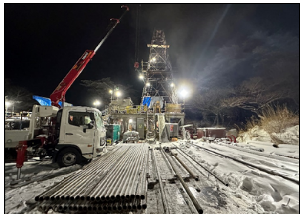
図2 硫黄山での掘削現場（24時間連続稼働）の様子
