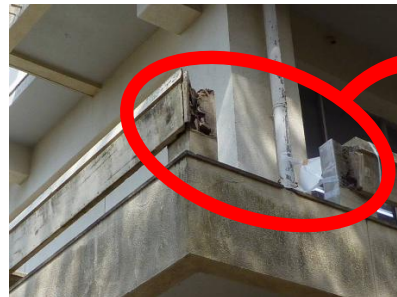
老朽化により手すりが落下
