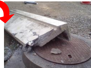
老朽化により手すりが落下
