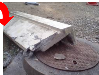
老朽化により手すりが落下
