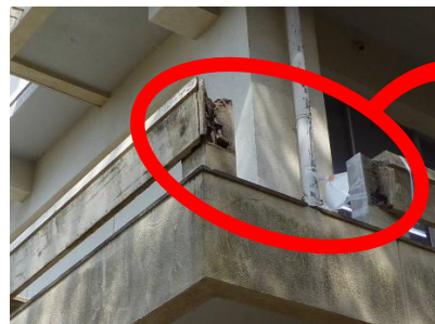
老朽化により手すりが落下
