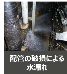
配管の腐食
