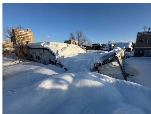
屋根への積雪による建物の一部倒壊
