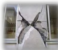
耐震化未完了の建物が 大規模地震により甚大な 被害を受けた例
