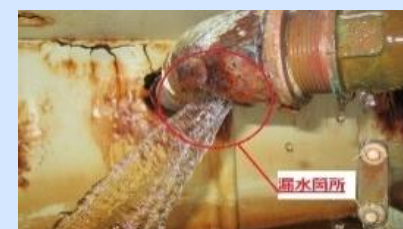
配管の破損
