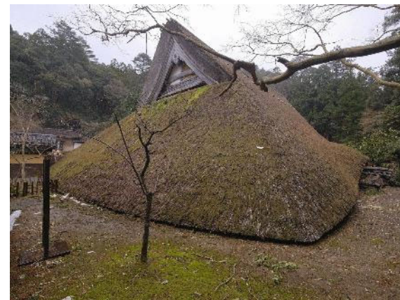
重要文化財上時国家住宅主屋ほか （石川県輪島市） 令和6年能登半島地震による主屋などの倒壊
