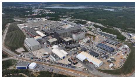
ITERサイトの建設状況
