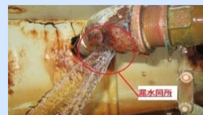
配管の破損
