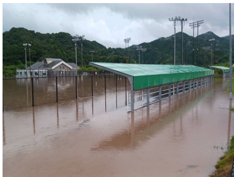
大雨被害による運動場の冠水
