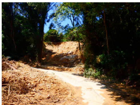
降雨による土砂流入
