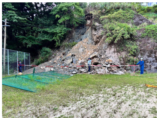
大雨被害による学校敷地内の法面崩落
