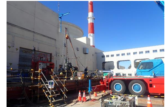
地盤改良の施工状況
