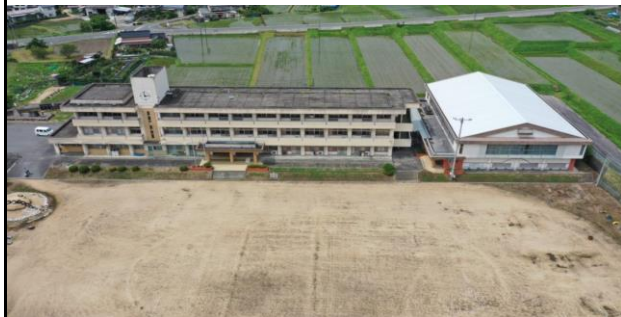
校舎等の外観写真
