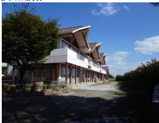
校舎等の外観写真
