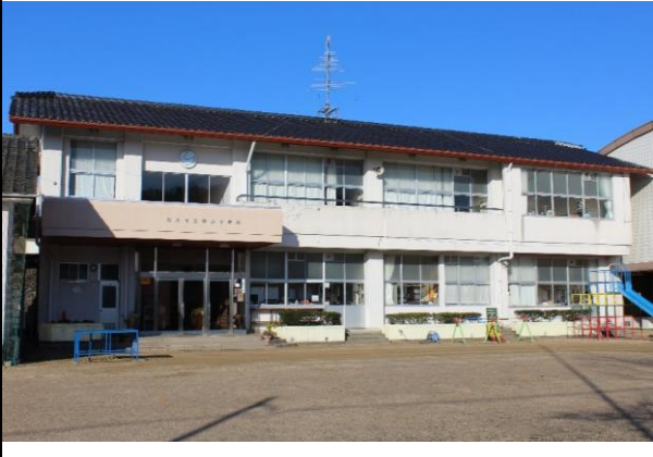
校舎等の外観写真
