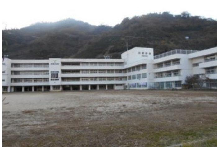
校舎等の外観写真
