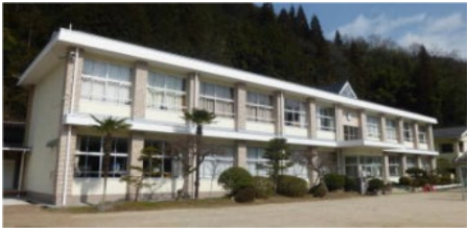
校舎等の外観写真
