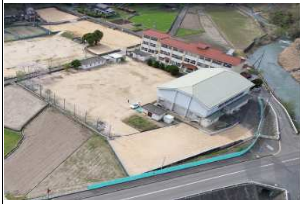
校舎等の外観写真
