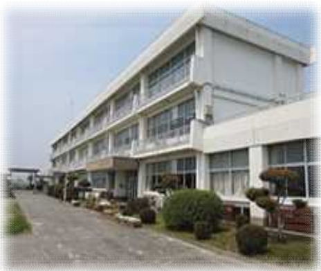
校舎の外観写真
