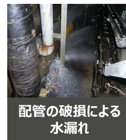
配管の腐食
