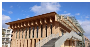
CLTを利用した施設（岡山大）
