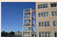
屋外階段（防災訓練）
