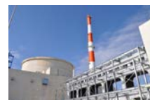
高速実験炉「常陽」
