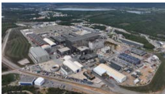
ITERサイトの建設状況
