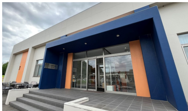
クライオ電顕実験棟
