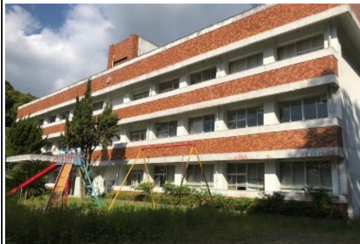
校舎等の外観写真
