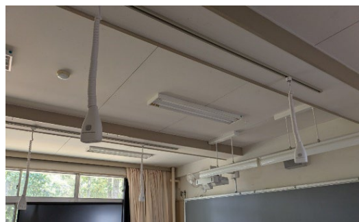
教室棟2階講義室コンセント設置費 リーラーコンセント
