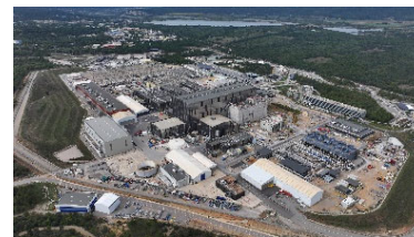
ITERサイトの建設状況
