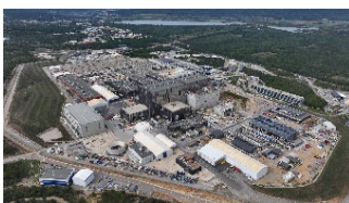
ITERサイトの建設状況
