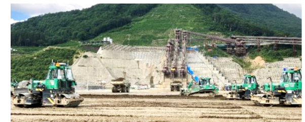
↑無人建機群による自動化施工システムの現場運用開始 鹿島建設
