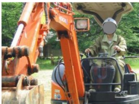
建設工学科の実技学習の様子
