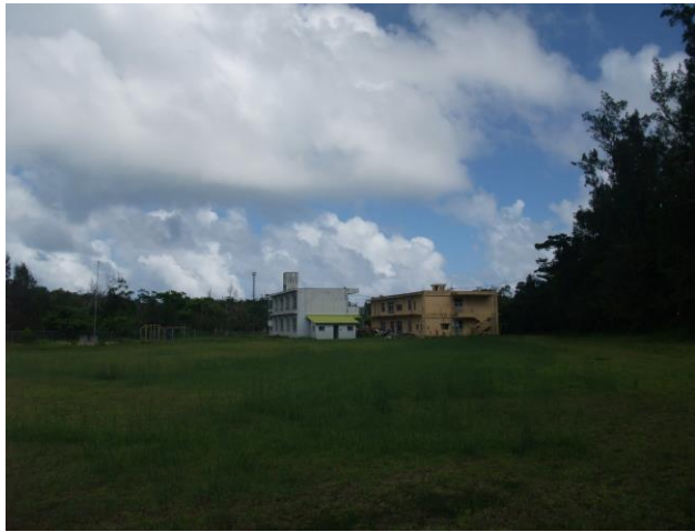
校舎等の外観写真
