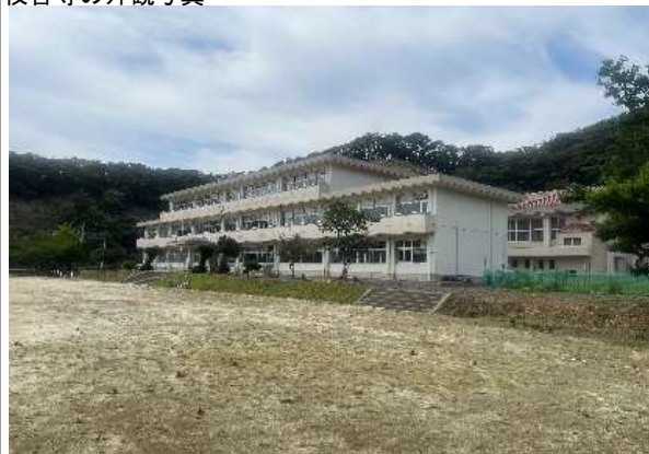
校舎等の外観写真
