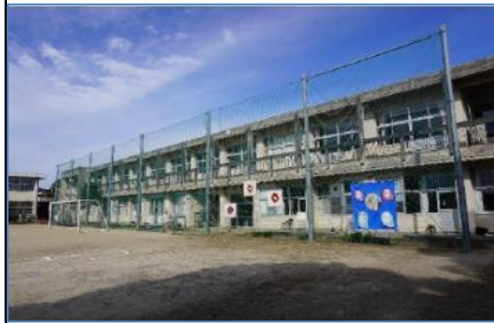
校舎等の外観写真
