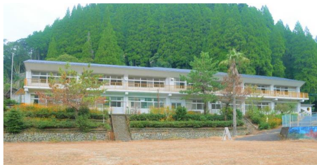
校舎等の外観写真
