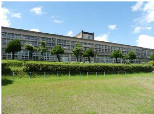
校舎等の外観写真
