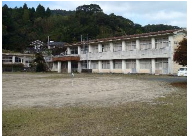
校舎等の外観写真
