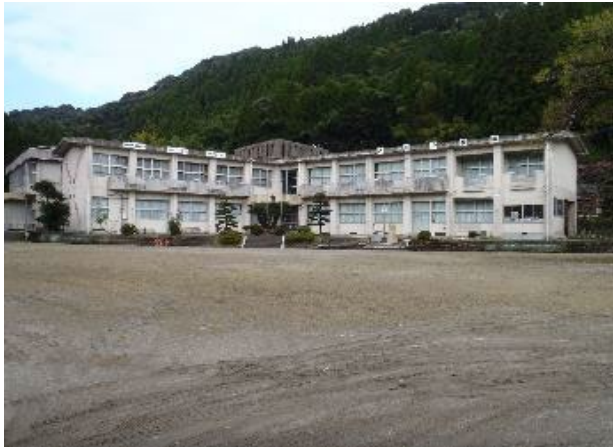
校舎等の外観写真
