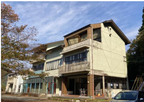
校舎等の外観写真
