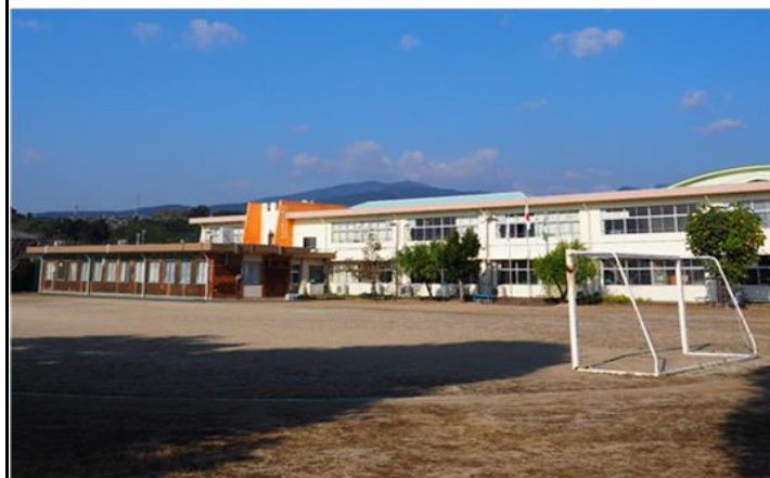
校舎等の外観写真
