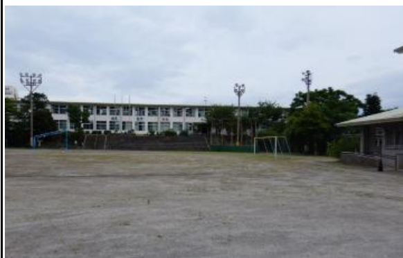
校舎等の外観写真
