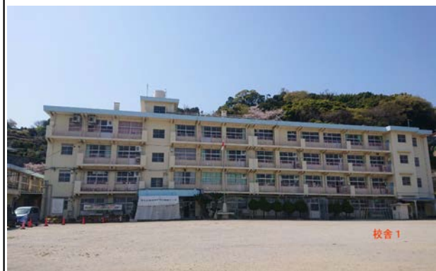
校舎等の外観写真
