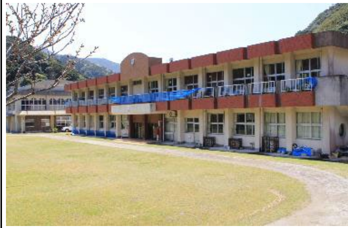
校舎等の外観写真
