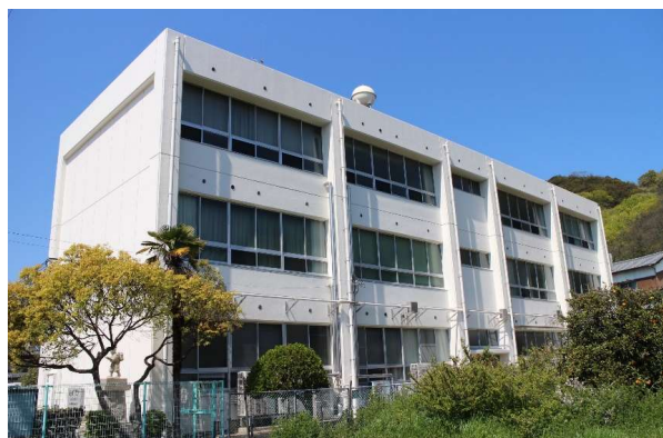
校舎等の外観写真
