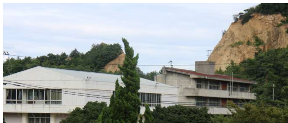
校舎等の外観写真
