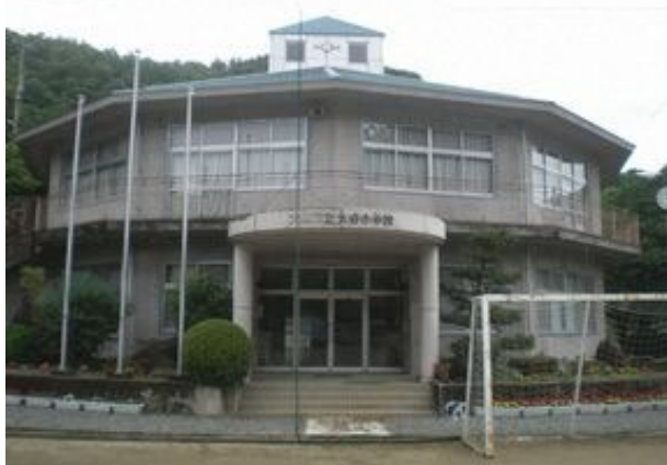
校舎等の外観写真
