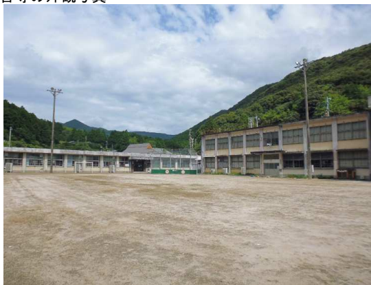
校舎等の外観写真
