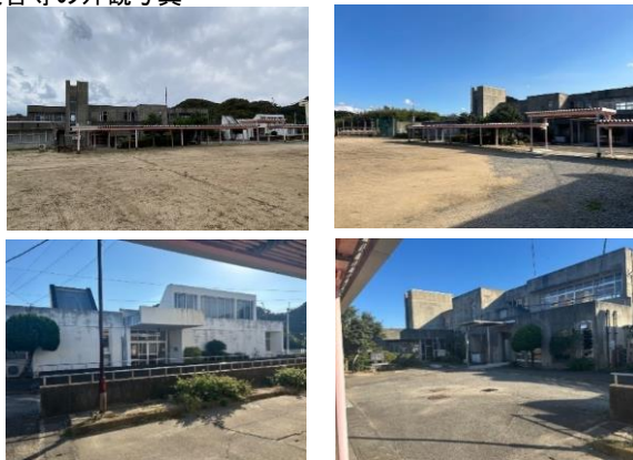
校舎等の外観写真
