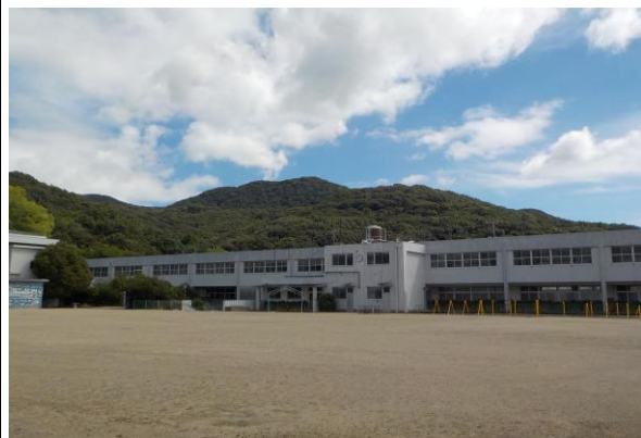
校舎等の外観写真
