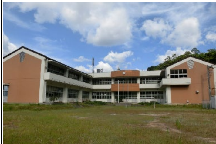
校舎等の外観写真
