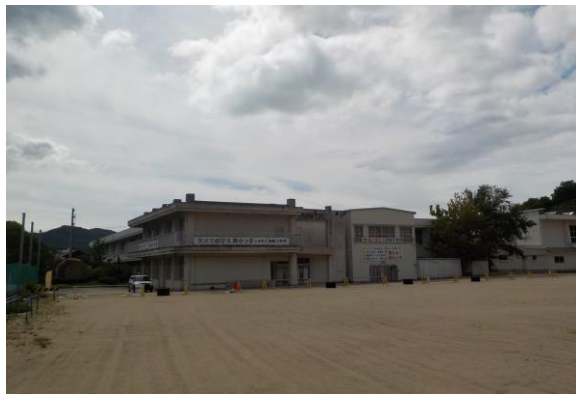
校舎等の外観写真
