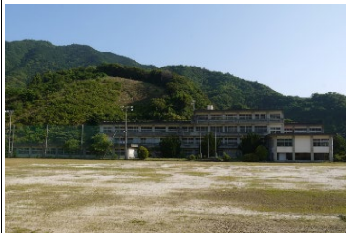
校舎等の外観写真
