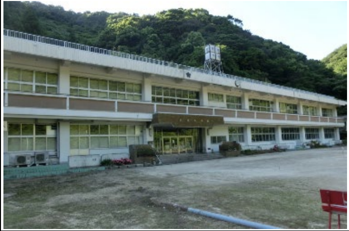
校舎等の外観写真
