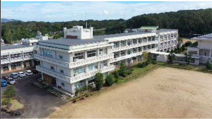
校舎等の外観写真
