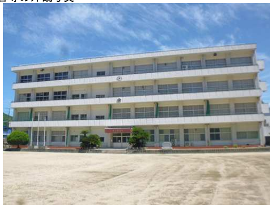
校舎等の外観写真
