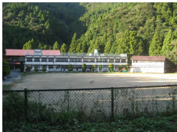
校舎等の外観写真
