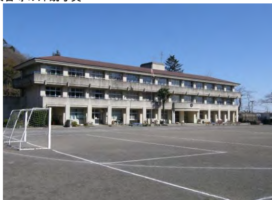
校舎等の外観写真
