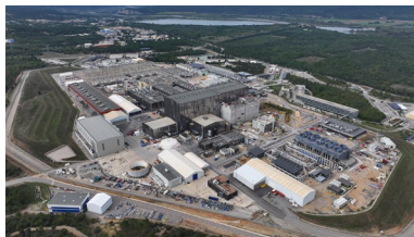
ITERサイトの建設状況
