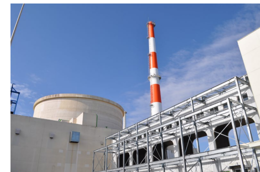
高速実験炉「常陽」
