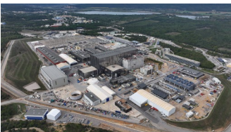
ITERサイトの建設状況
