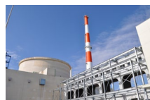
高速実験炉「常陽」
