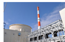
高速実験炉「常陽」
