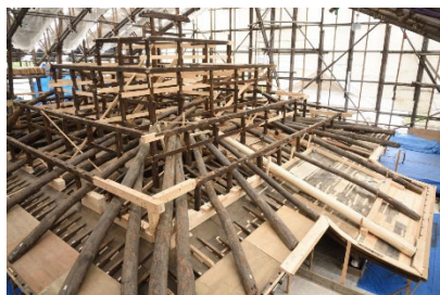
小屋組の修理状況 【重要文化財 本隆寺祖祠堂（京都府京都市）】
