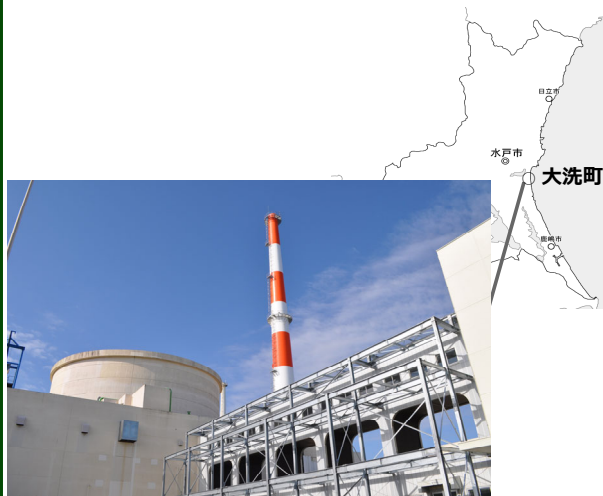
高速実験炉「常陽」
