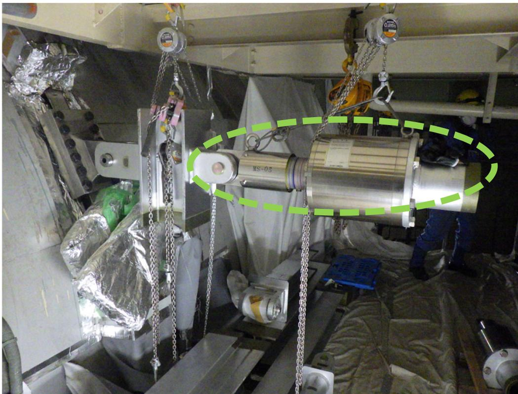
配管支持装置の新設（メカニカル防振器）
