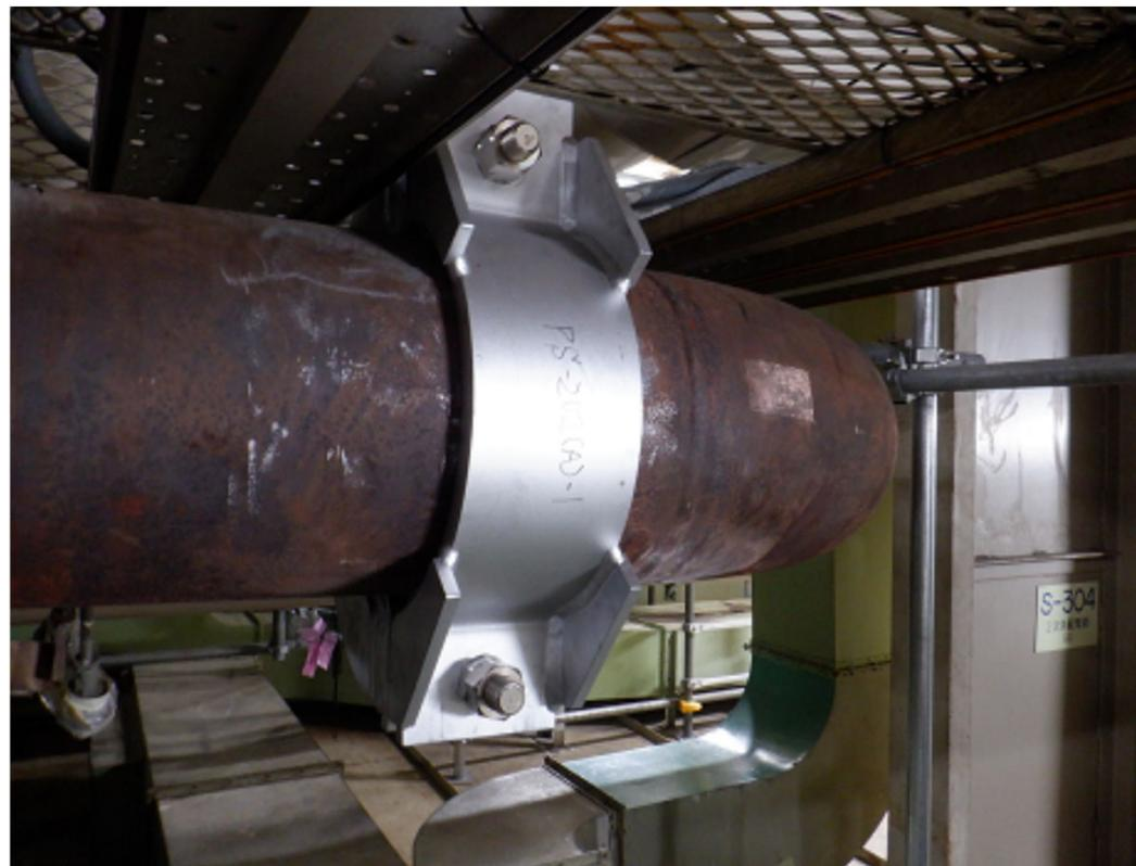
配管支持装置の交換
