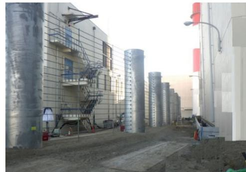
津波漂流物防護柵(押し波)の設置状況
