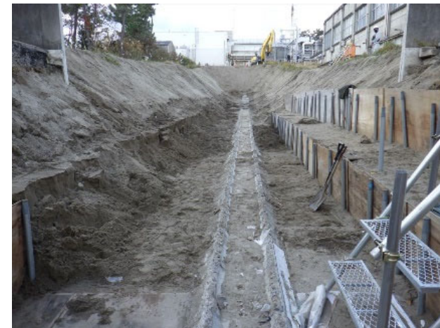
解体・撤去後
