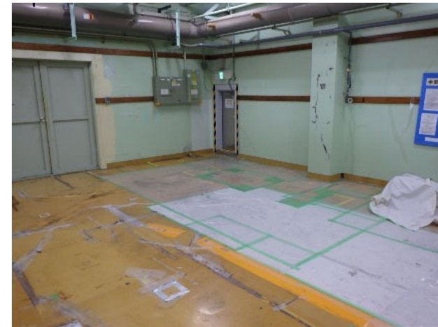
解体・撤去後
