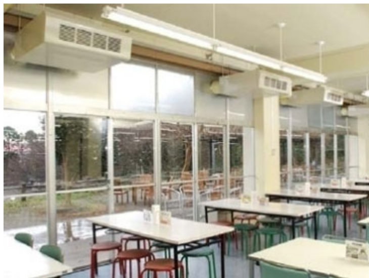
図 3-37 天吊形全熱交換器の設置例
