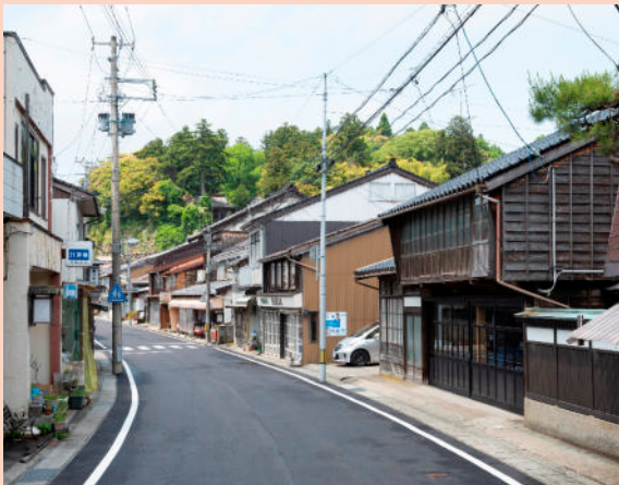
佐渡市小木町伝統的建造物群保存地区（写真提供：佐渡市役所）
