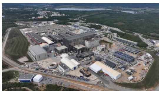
ITER（国際熱核融合実験炉）の建設状況（2024年10月） 南仏（サン・ポール・レ・デュランス） ©ITER Organization
