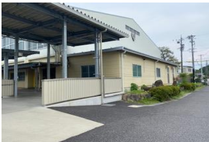
屋内運動場(外観)
