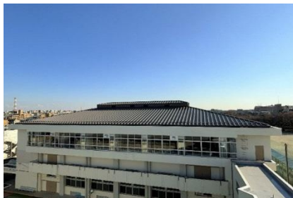
屋根遠景(施工後)
