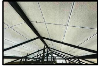
天井材設置完了状況
