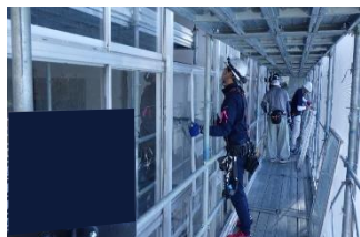
既存サッシ撤去
