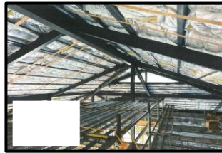
天井(断熱材設置完了状況)
