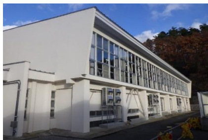
屋内運動場(外観)
