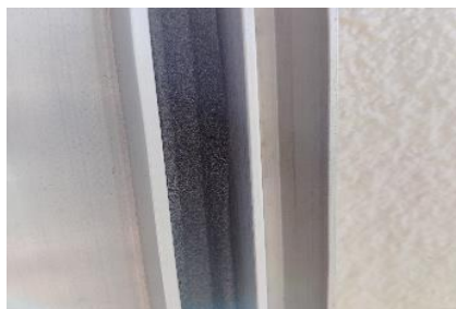
1階窓隙間風対策
