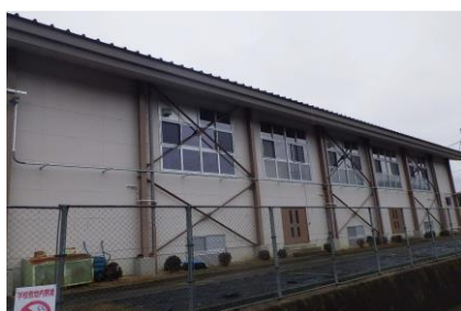
建具・窓ガラス断熱工事施工後
