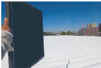
屋根(遮熱塗装後)
