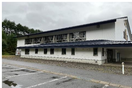
屋内運動場(外観)
