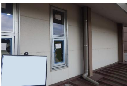
窓ガラス断熱工事施工後
