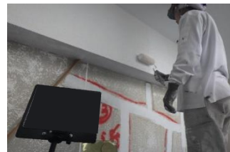
外壁断熱塗装
