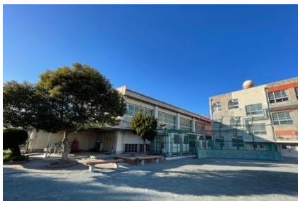
屋内運動場(外観)
