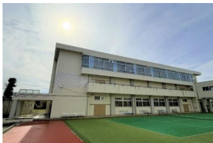
屋内運動場(外観)
