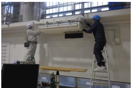
天井吊型空調機(施工状況)
