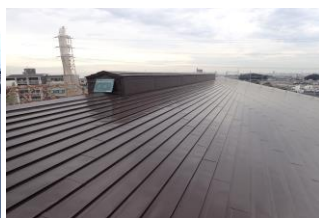
屋根(遮熱塗装施工後)
