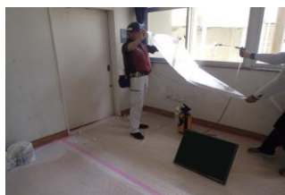
窓(日射調整フィルム施工中)
