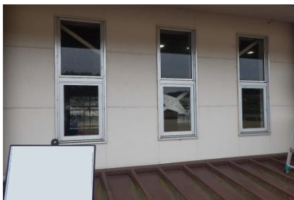
窓ガラス断熱工事施工前
