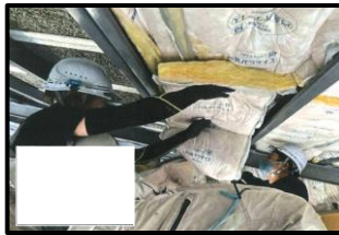
天井(断熱材設置状況)
