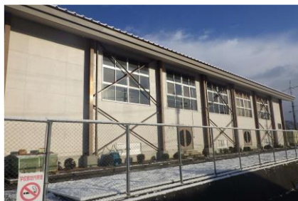
建具・窓ガラス断熱工事施工前
