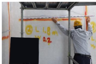
外壁クラック補修
