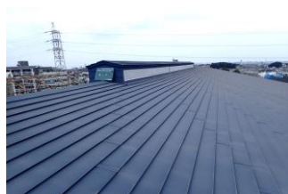
屋根(遮熱塗装施工前)
