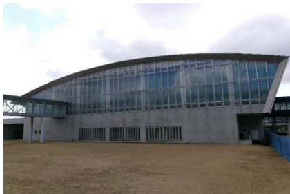
屋内運動場(外観)
