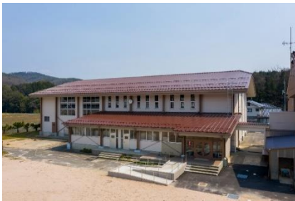
屋内運動場(外観)
