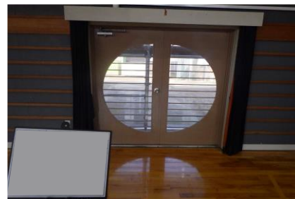
建具・窓ガラス断熱工事施工前
