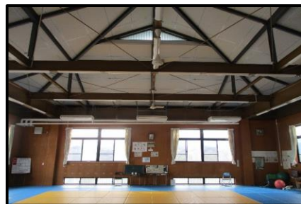
武道場(内観・柔道場)
