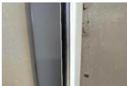
1階扉隙間風対策
