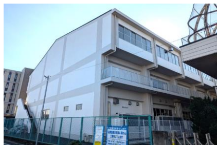
屋内運動場(外観)
