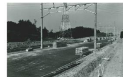
北総鉄道の工事現場は子どもたちにとって巨大な「あそび」場だった
