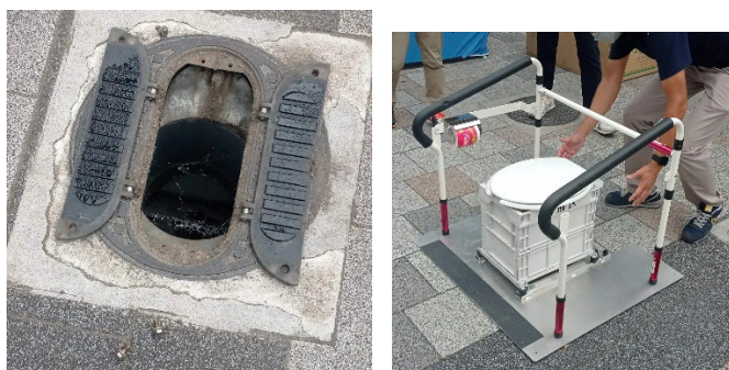
図 3 マンホールの穴を活用したトイレ 東京都葛飾区
