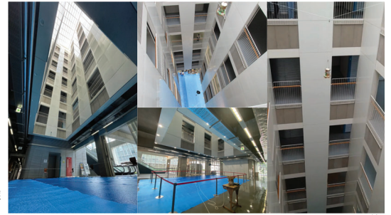
↑床保護用のブルーシート ↑バリケード（1階） ↑落下装置
