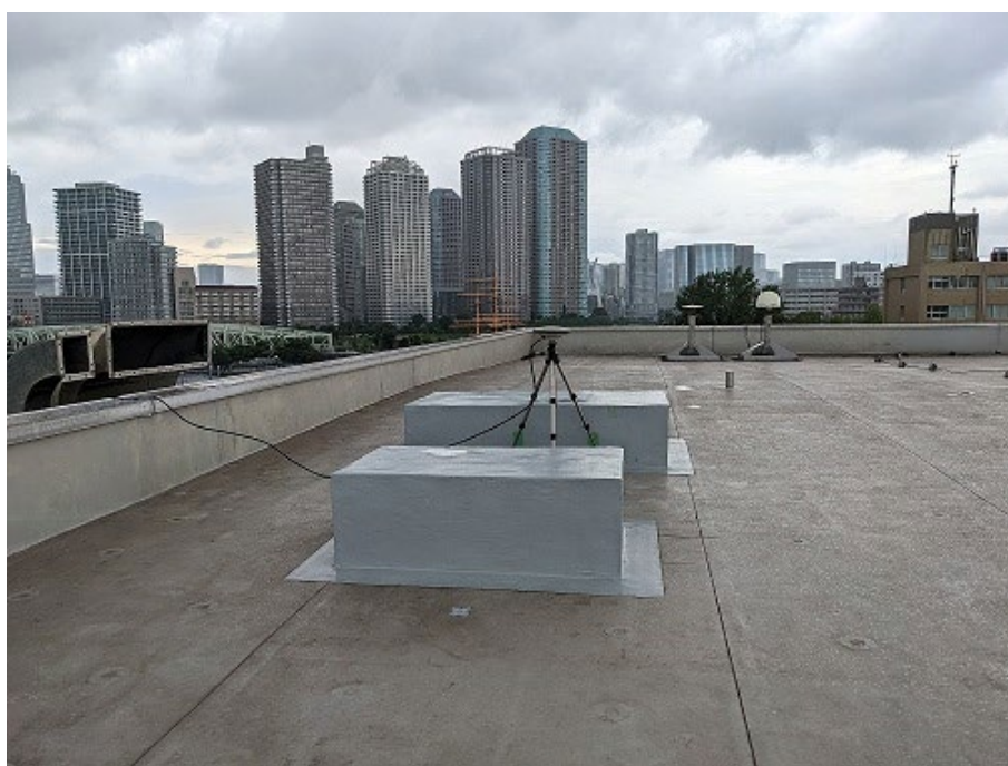
【図2.2.2a：第1回目セミナー時の屋上アンテナ】
