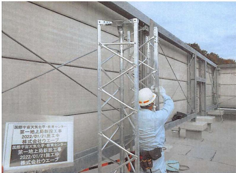
図 5.2.1 アンテナ施工の様子（1）
