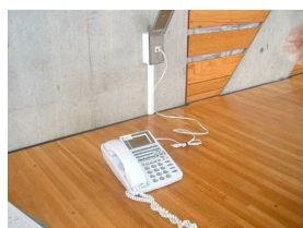
屋内運動場に 電話回線の設置
