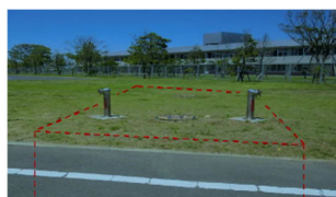
耐震性貯水槽
