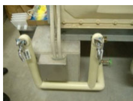
受水槽に蛇口を設置
