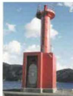
③三机港須賀 防波堤灯台
