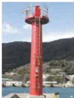
⑥伊予三崎港 三崎第一防波堤灯台
