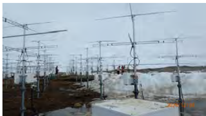
PANSYレーダーの 保守・管理
