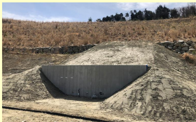
実証実験用擁壁
